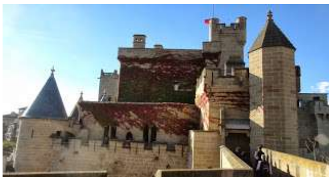
Otra vista parcial interior
